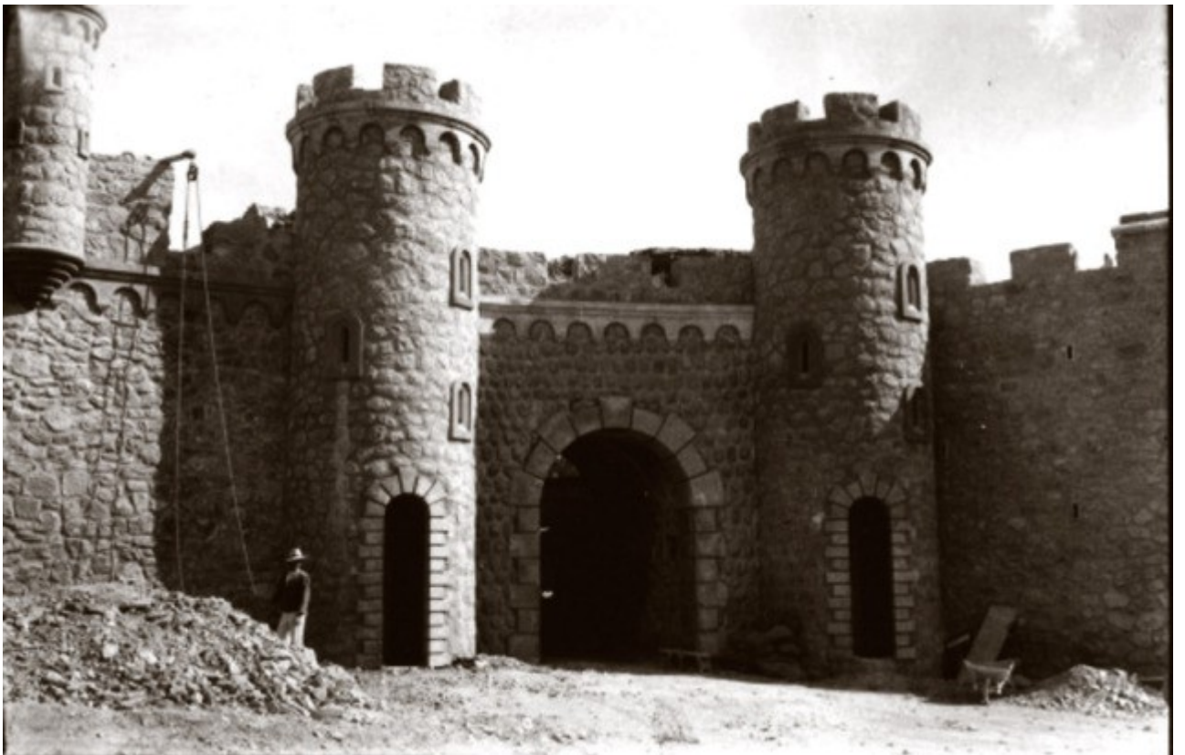
Pórtico de entrada a uno de los fosos subterráneos.
