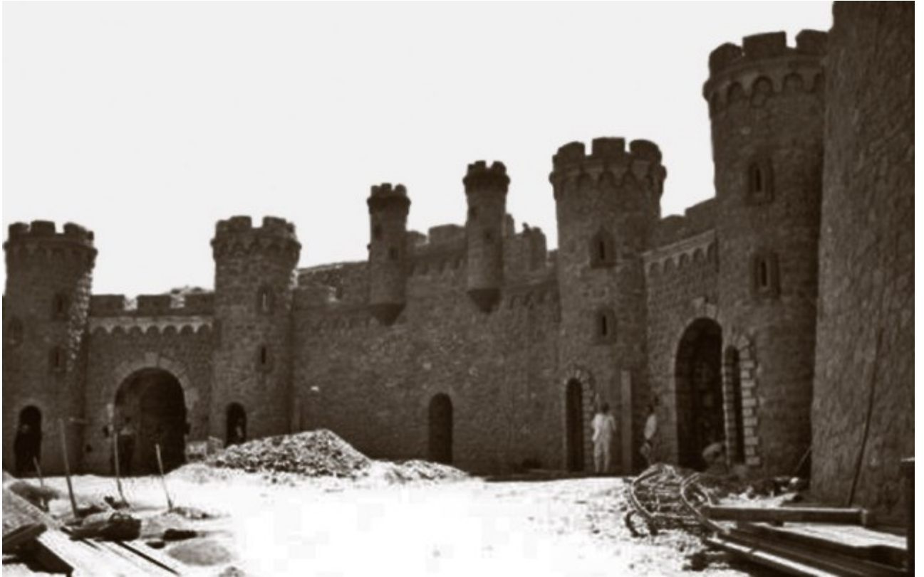
Construcción del pórtico de entrada a los fosos de los cañones y a la Dirección de Tiro .
