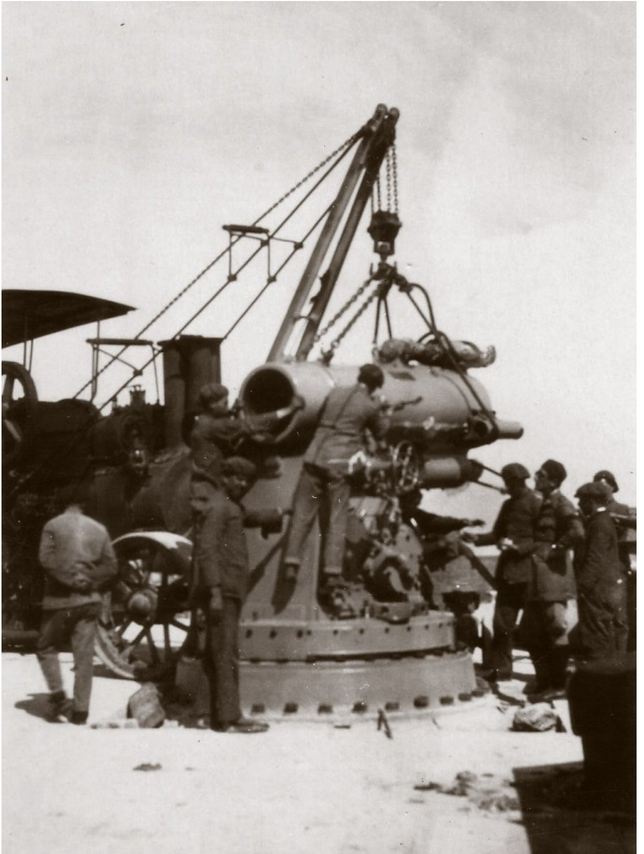
Montaje de uno de los 15'24 en la batería del Jorel.
