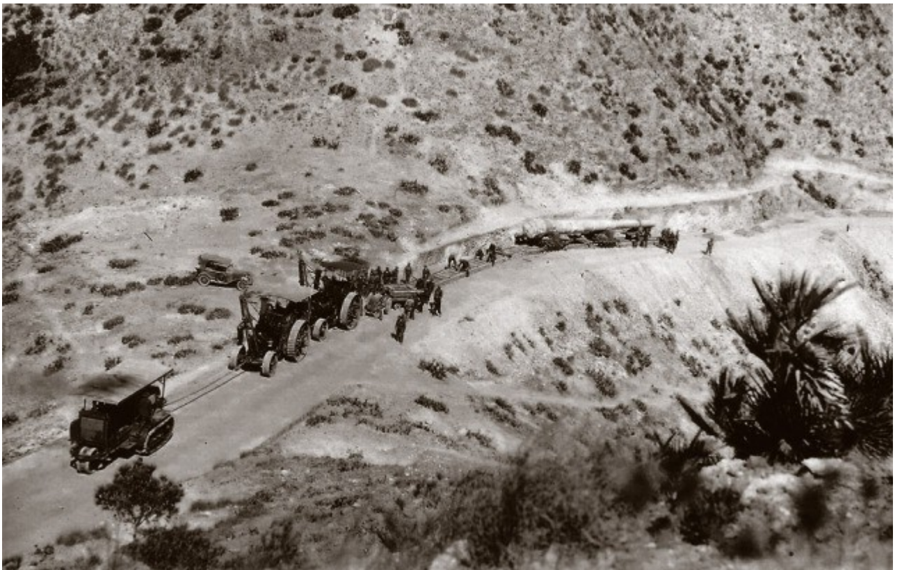
Transporte de diverso material sobre railes recuperables.
