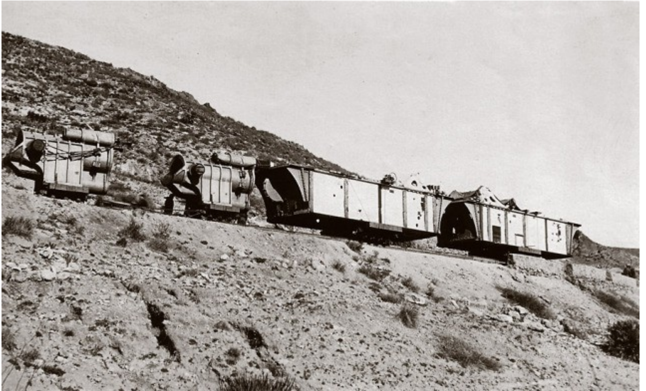
Transporte de diverso material sobre railes recuperables.
