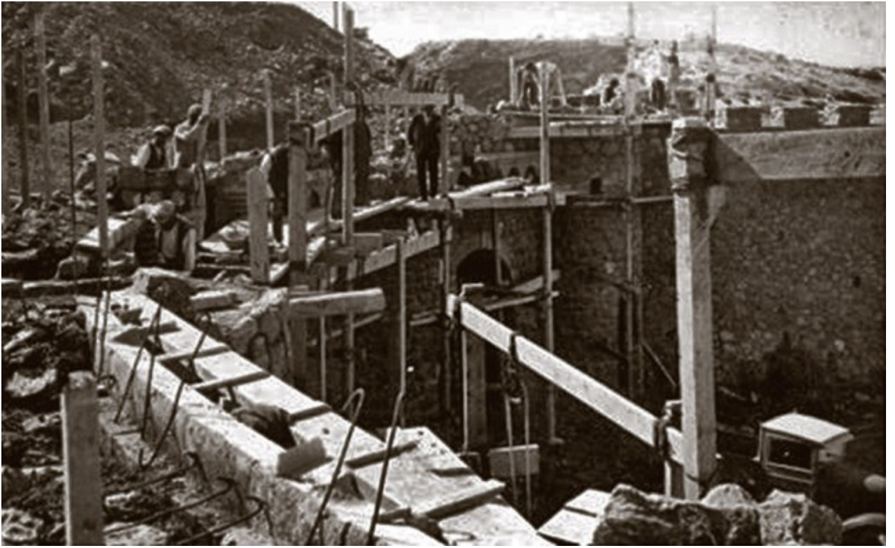
Construcción de los edificios.
