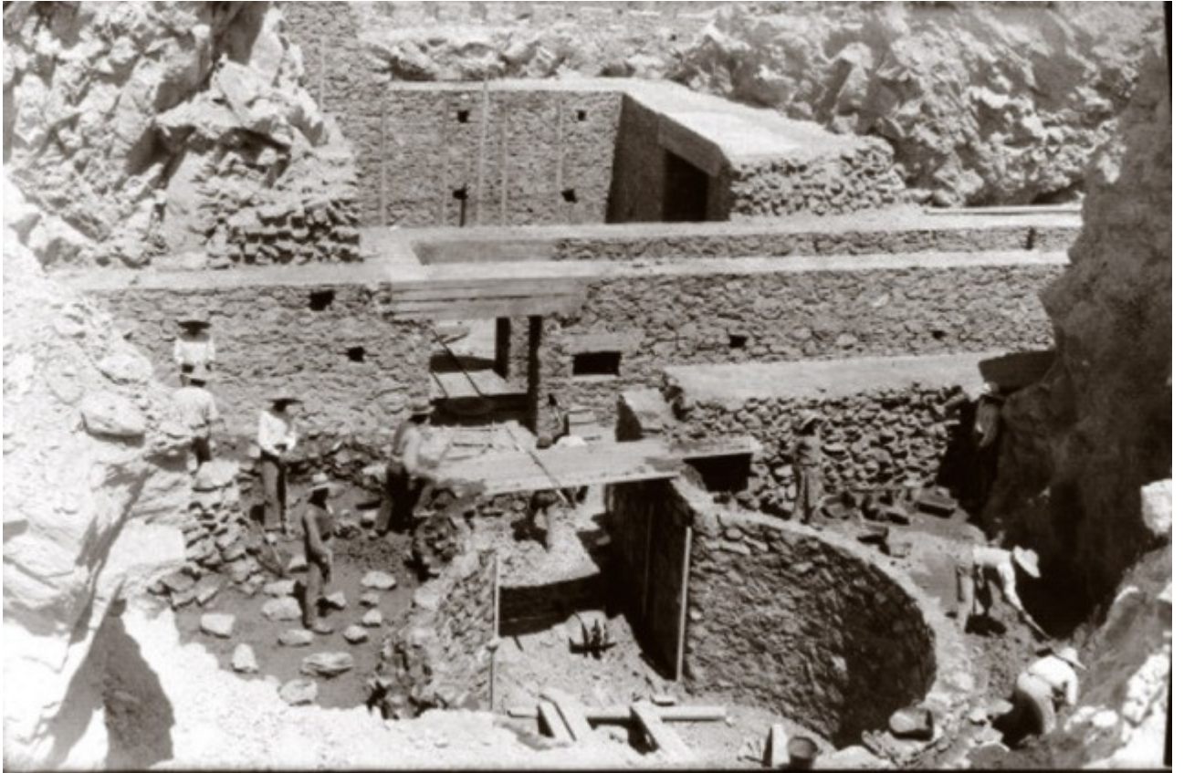
Construcción de un pozo para la ubicación de una de las piezas.
