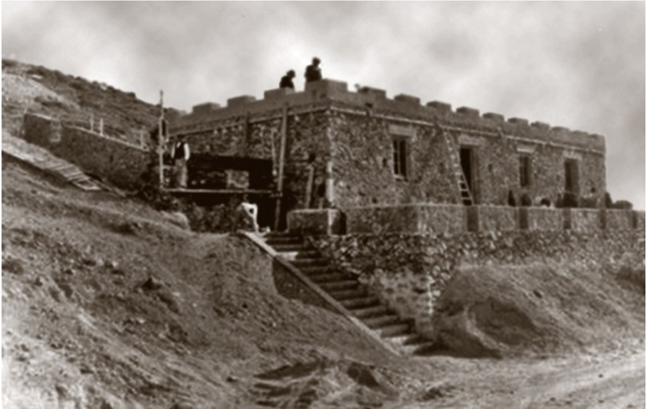
Uno de los edificios que forman parte del conjunto del Jorel.
