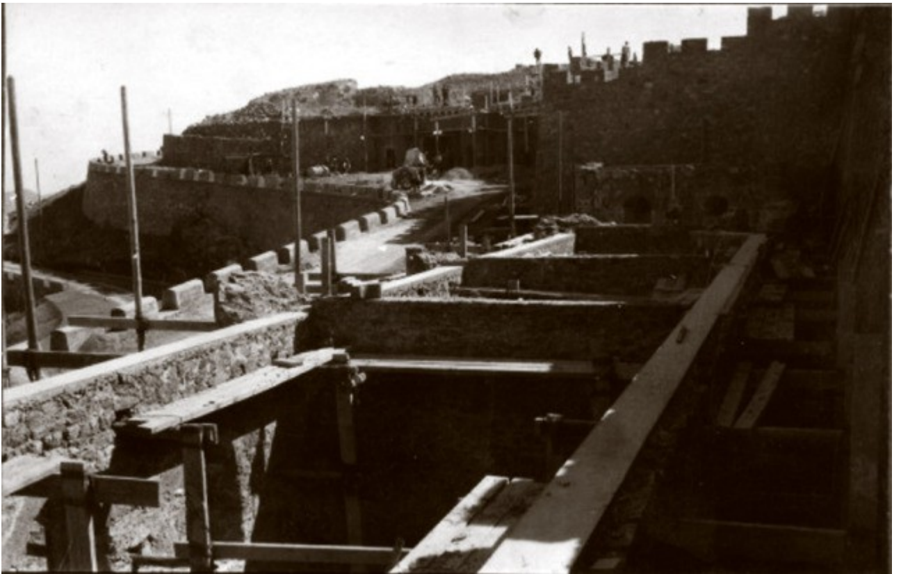
Construcción de los edificios.
