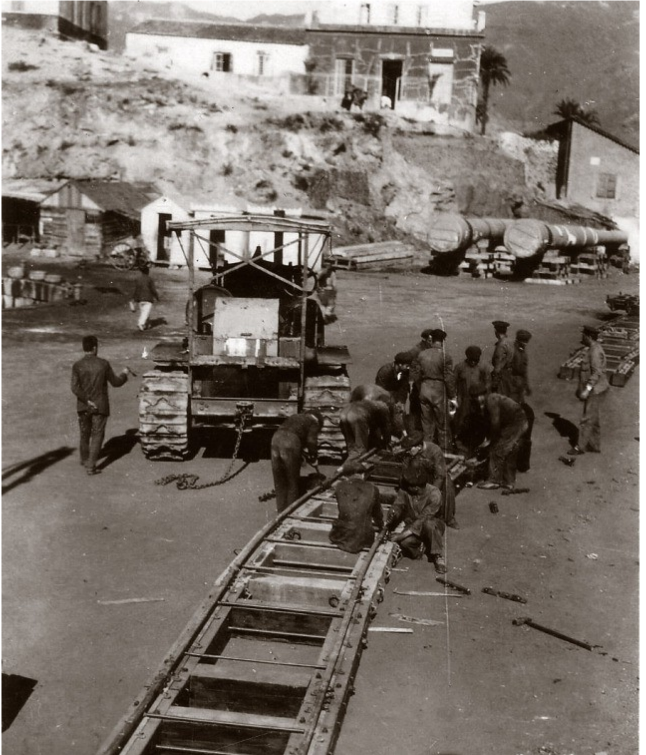
Las dos piezas de 38'1 esperan a ser trasladadas. Mientras, los operarios montan los railes por donde se desplazarán.
