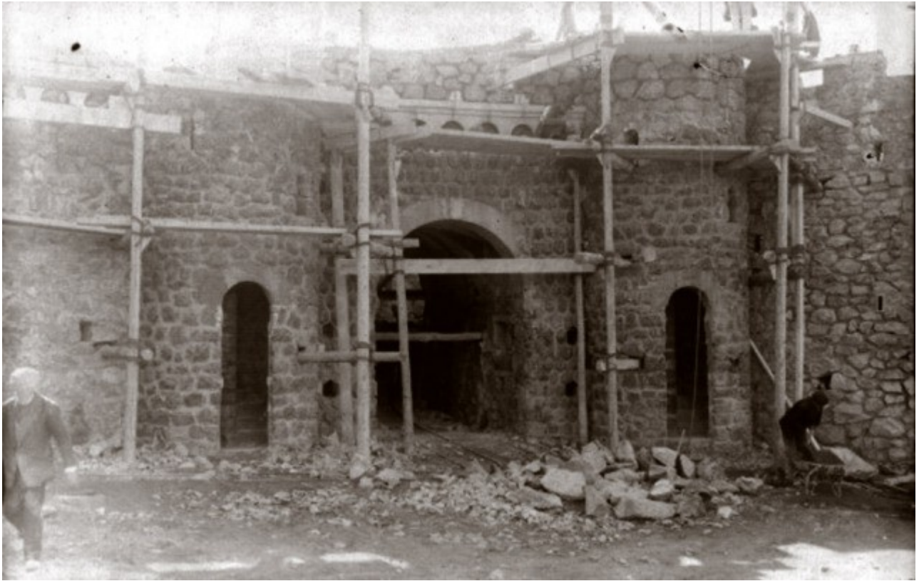
Construcción del pórtico de entrada a los pozos.
