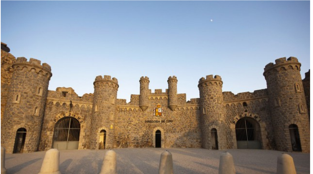
Imagen actual del pórtico de entrada a los pozos de las piezas y a la Dirección de Tiro de Castillitos
