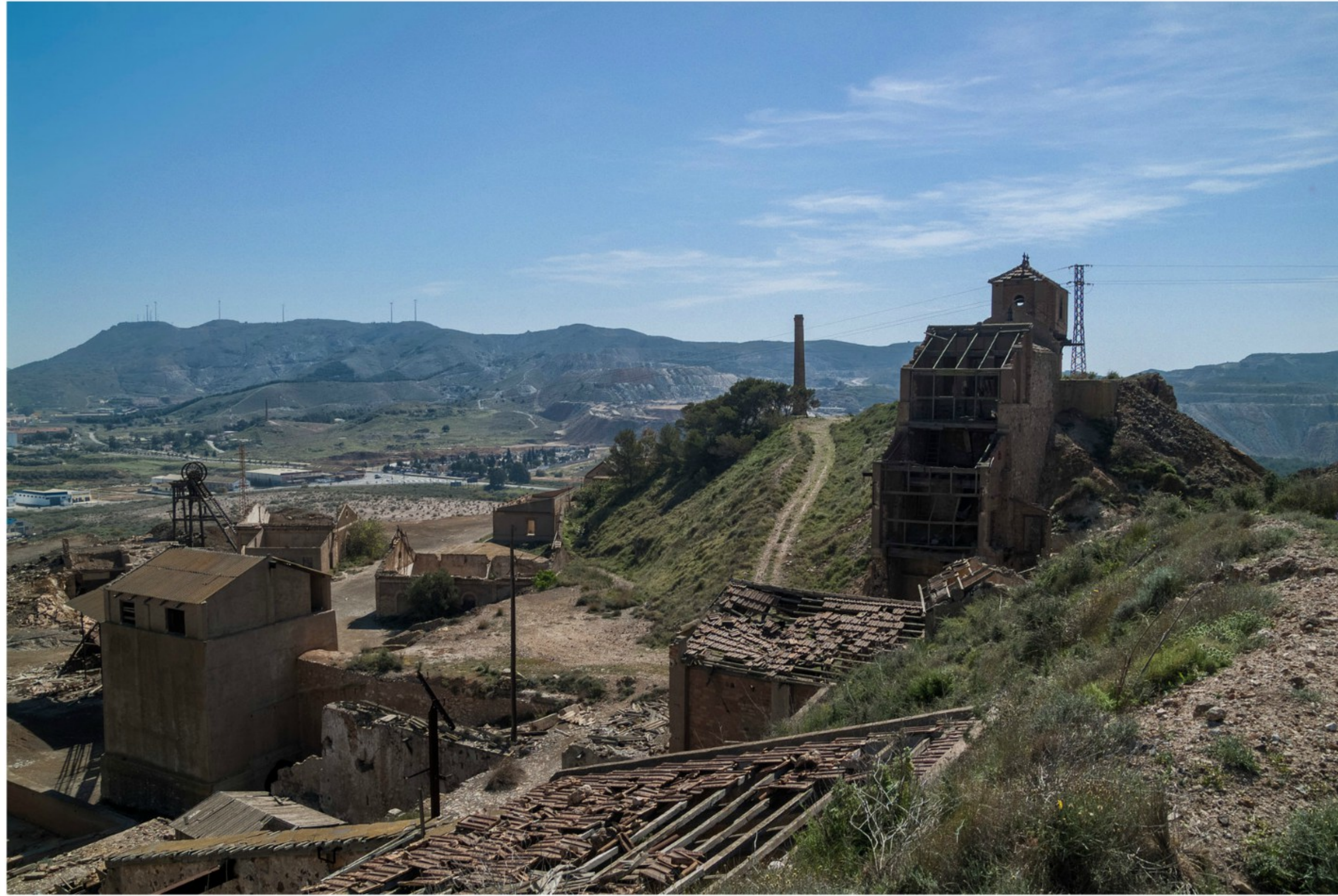
Instalaciones y transformador Cabezo Rajao - La Unión
