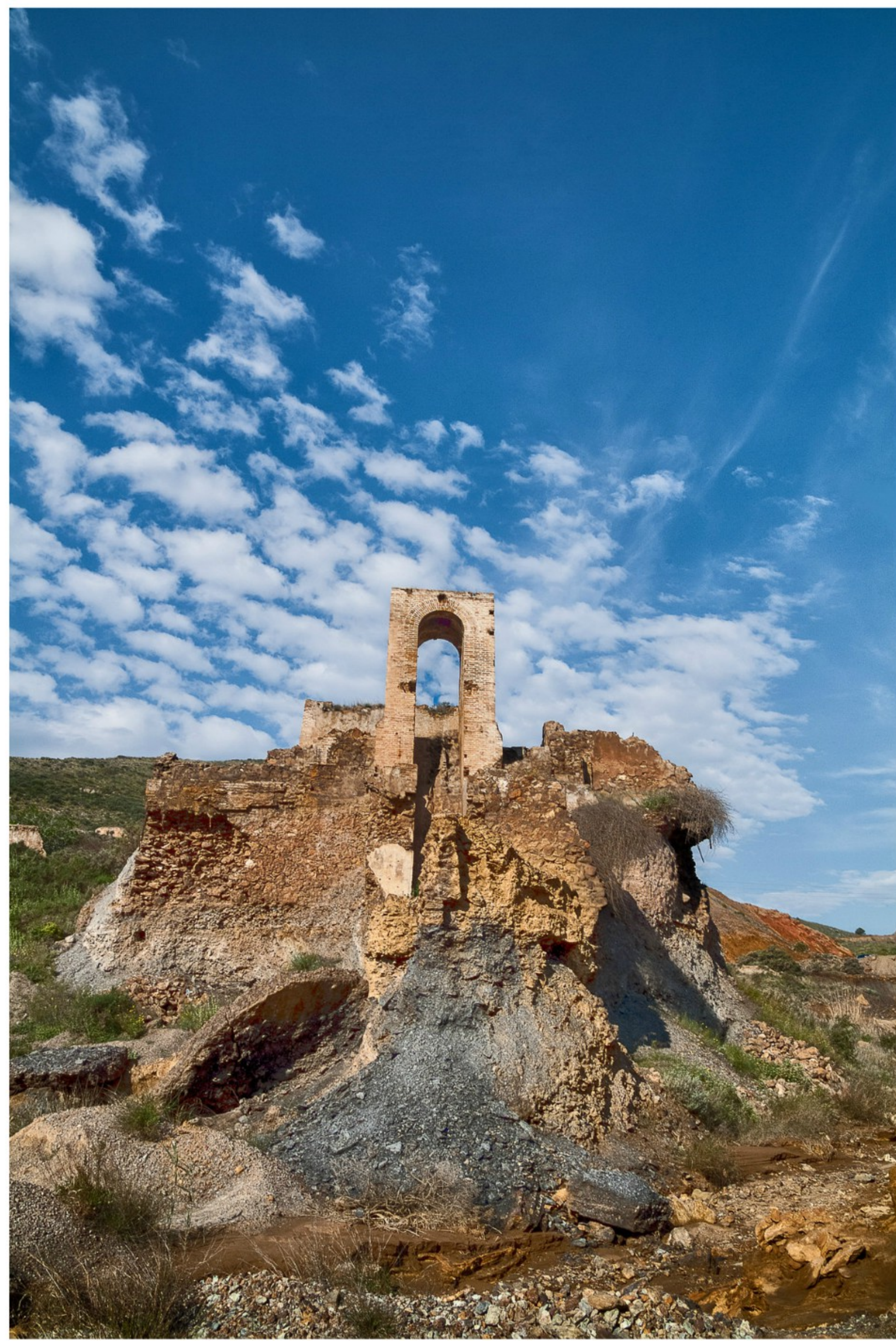
Castillete de mampostería y ladrillo. Mina Inocente, El Gorguel
