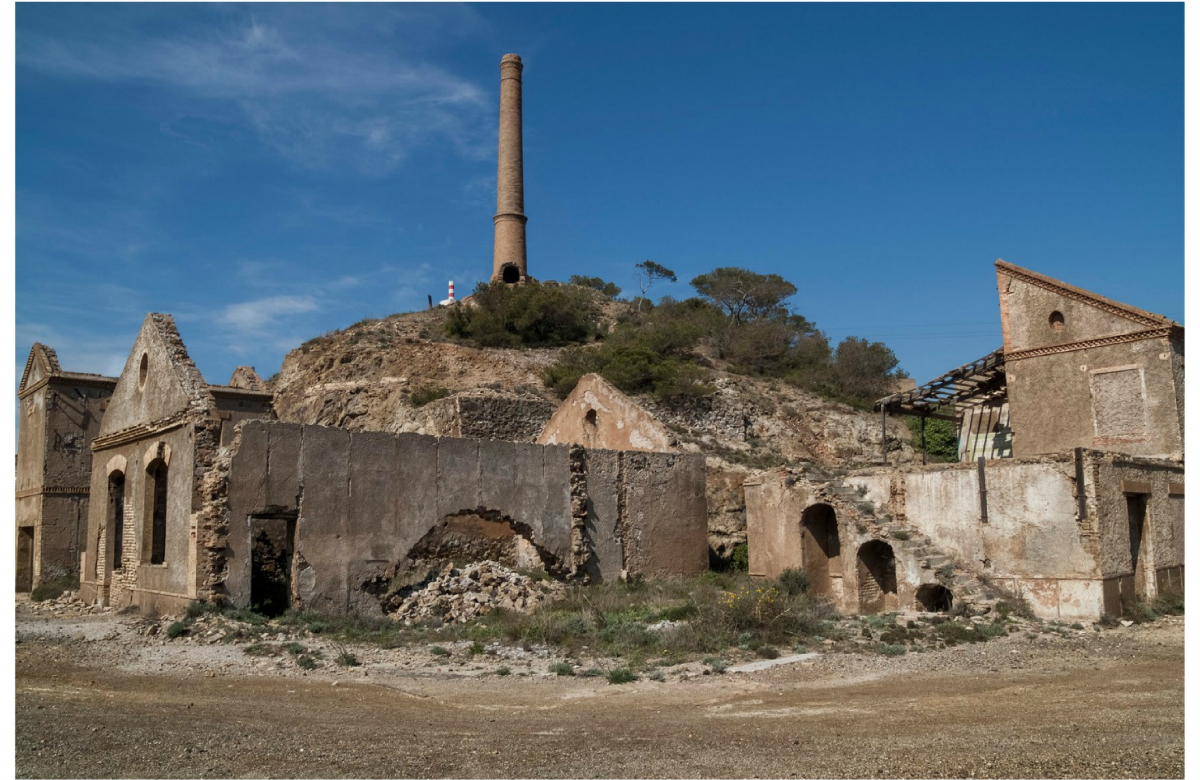
Oficinas y chimenea de la Mina La Palmera Cabezo Rajao - La Unión Es el principal distrito minero de la región. La zona minera ocupa una superficie rectangular, alargada en dirección noreste suroeste, de unos 10 x 5 km, que encierra la mayor acumulación de plomo y cinc y una de las principales de la Península Ibérica. A partir de 1839 se dio un fulgurante despegue de la minería, y en sólo unos pocos años se contabilizan más de 1.500 minas en la sierra.
