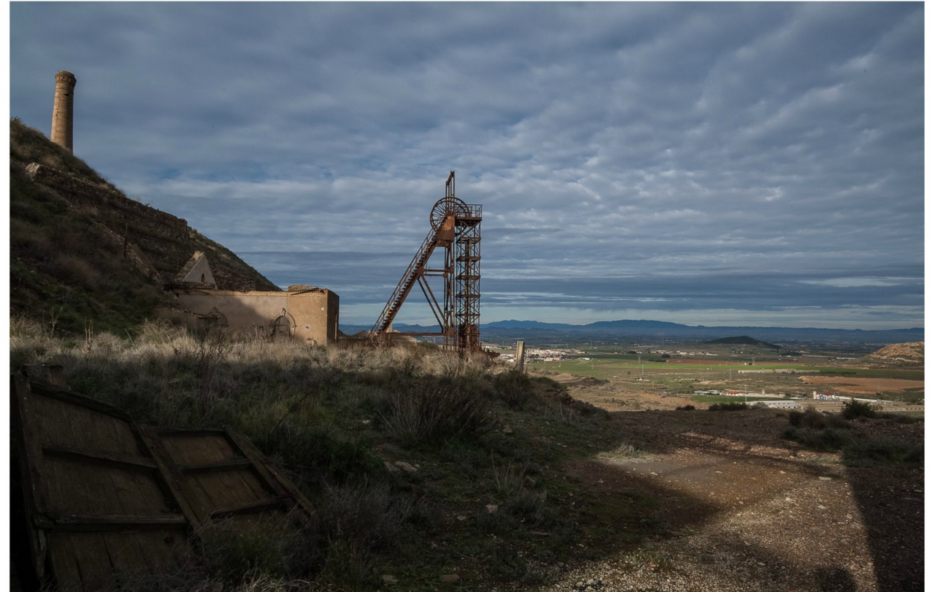
Castillete e instalaciones Mina Nuestra Señora de Monserrat Cabezo Rajao - La Unión
