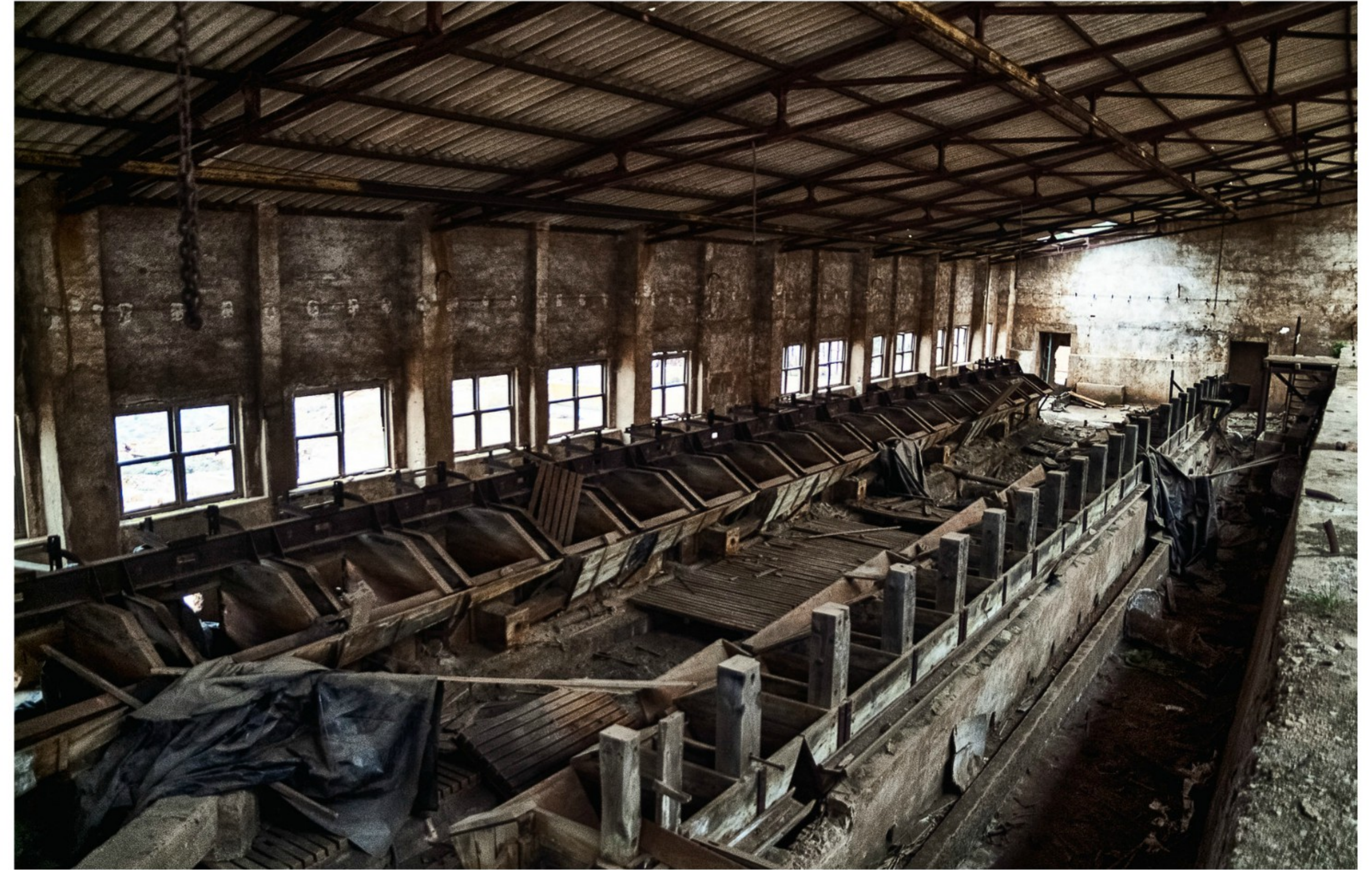
Lavadero Mina Nuestra Señora de Monserrat Cabezo Rajao - La Unión -Dos líneas de batería de celdas o vagonetas con unas 20 celdas -Balsas de secado de mineral en el exterior
