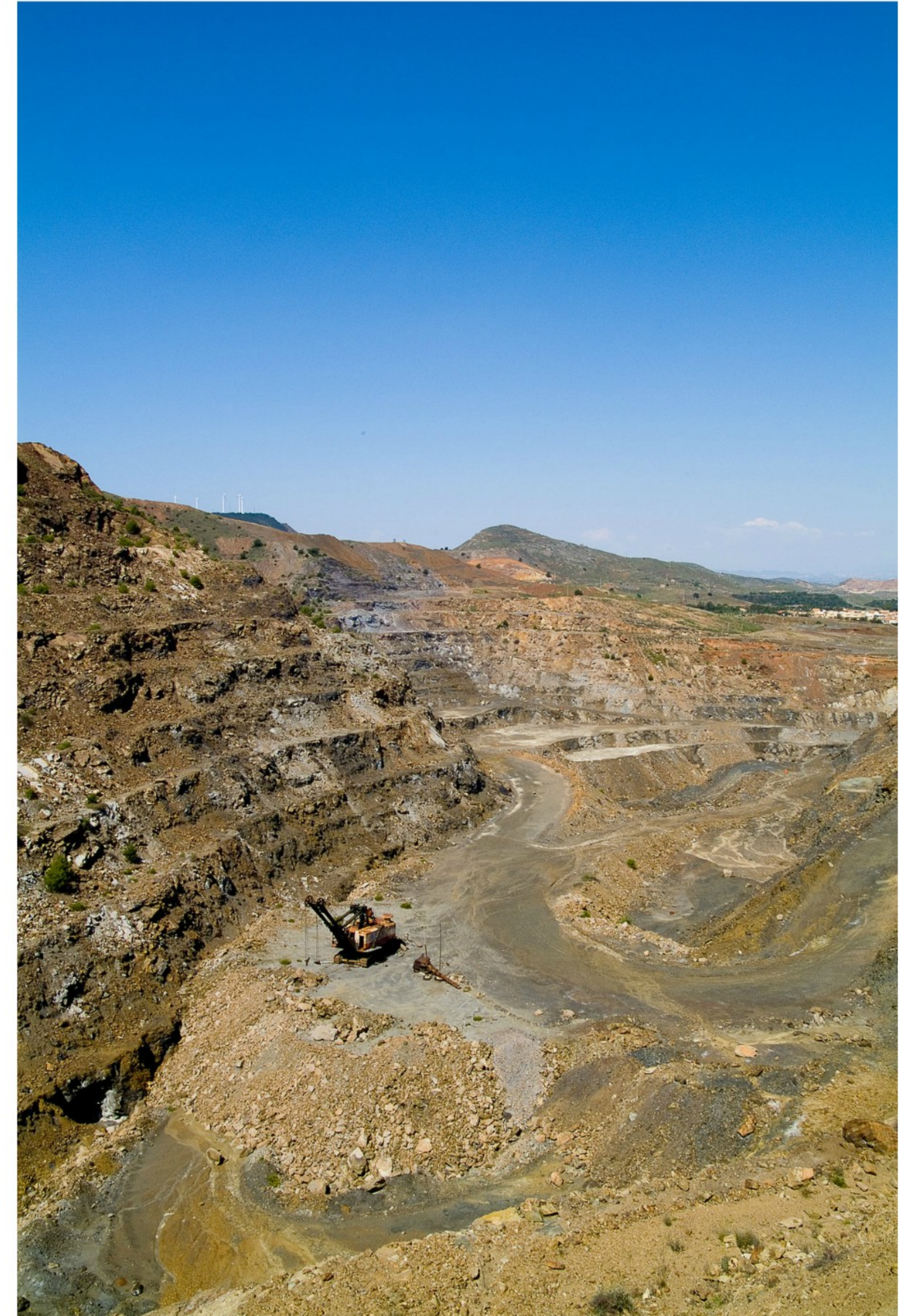
Corta Sultana - Llano del Beal Explotación a cielo abierto con extracción de Blenda y Galena. Sultana permitió explotar en superficie, y por lo tanto hacer rentables, multitud de concesiones mineras. Entre ellas cabe destacar: Sultana, Yenny, La Pagana, Estrella, Belén, etc. En esta corta existe otra excavadora idéntica a la Corta Brunita, Ruston Bucyrus, nº 25, hoy desaparecida.
