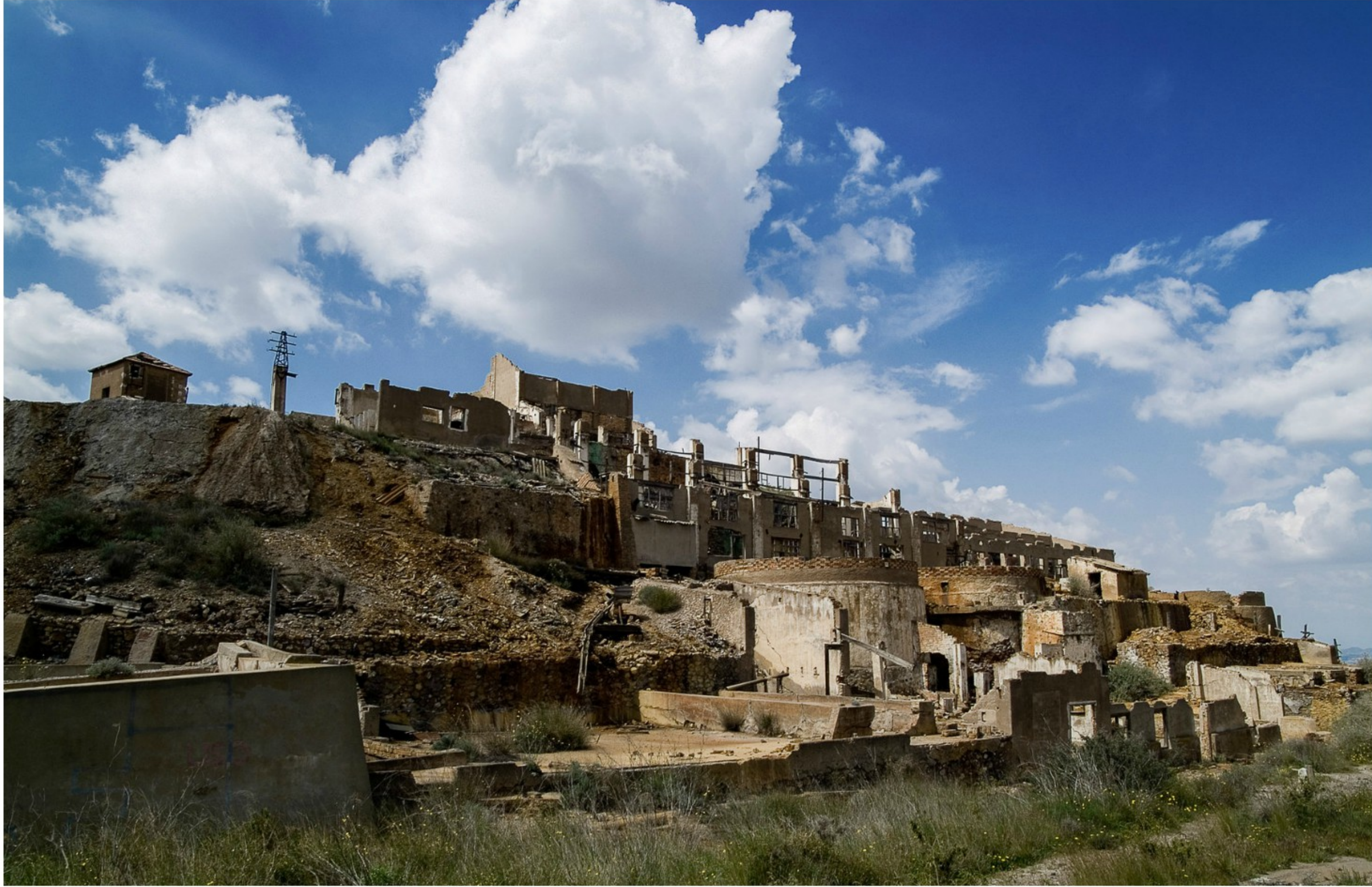
Lavadero de Santa Teresa, paraje de Las Pocilgas - La Unión. Lavadero de flotación diferencial. Perteneció a la empresa minera Eloy Celdrán. Se trata de unas instalaciones dispuestas a lo largo de la vertiente de una pequeña colina en distintas terrazas. En la zona superior nos encontramos con los depósitos de reactivos y una tolva en la que desembocaba un transporte de obra del que quedan algunos restos. En el piso intermedio aparecen tres molinos de bolas que se conservan in situ en relativo buen estado. En el piso inferior aparecen las baterías de celdas de madera donde se realizaba la separación entre el mineral y el estéril, y ya fuera del edificio y a un nivel inferior se pueden ver las balsas de secado. El lavadero tiene otras estructuras asociadas como oficinas, almacenes e incluso una edificación con unos antiguos hornos para realizar pruebas de fundición.
