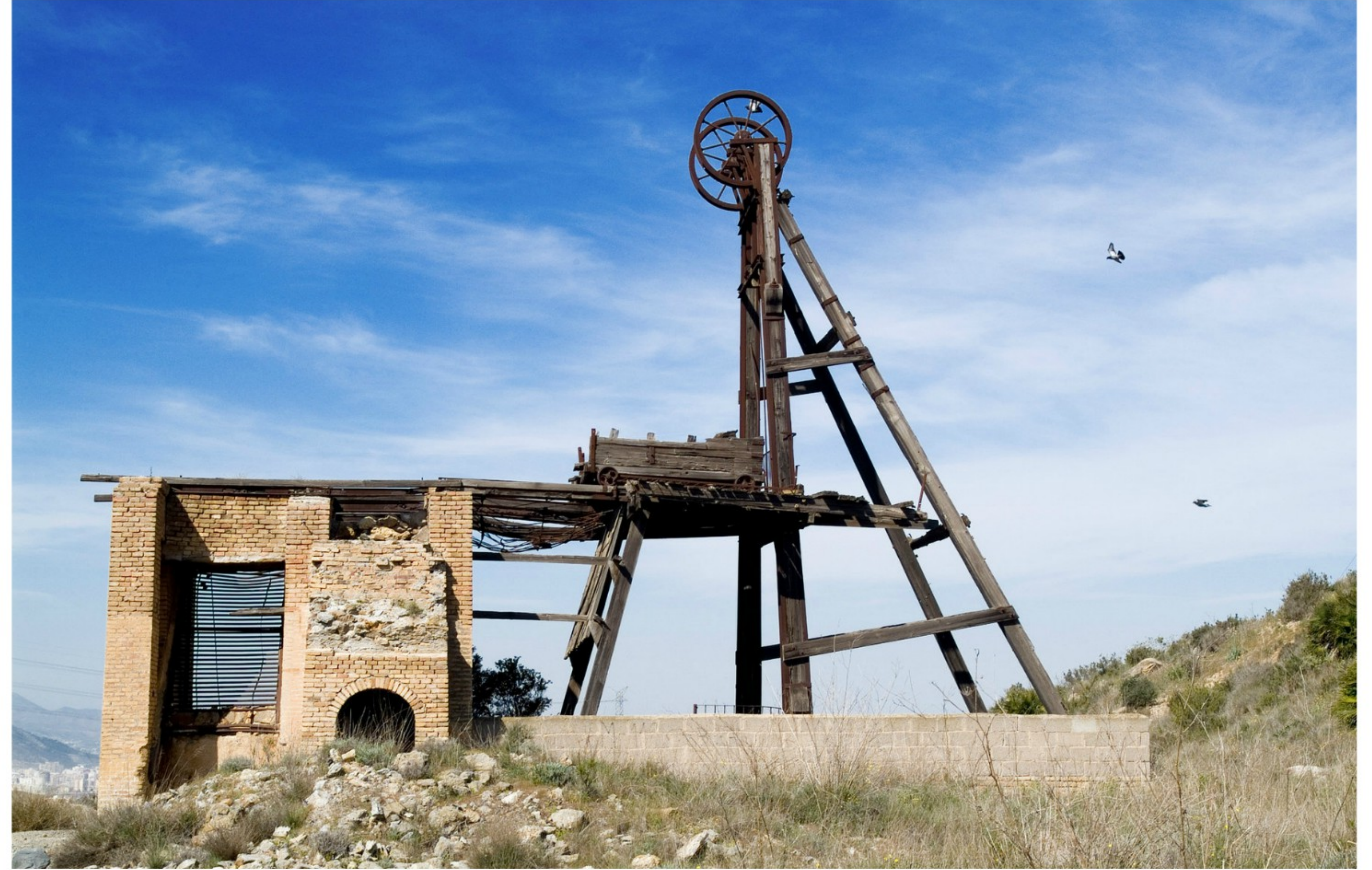
Castillete de la Mina San Simón. Cerro de La Parreta, Alumbres Derruido en junio de 2012
