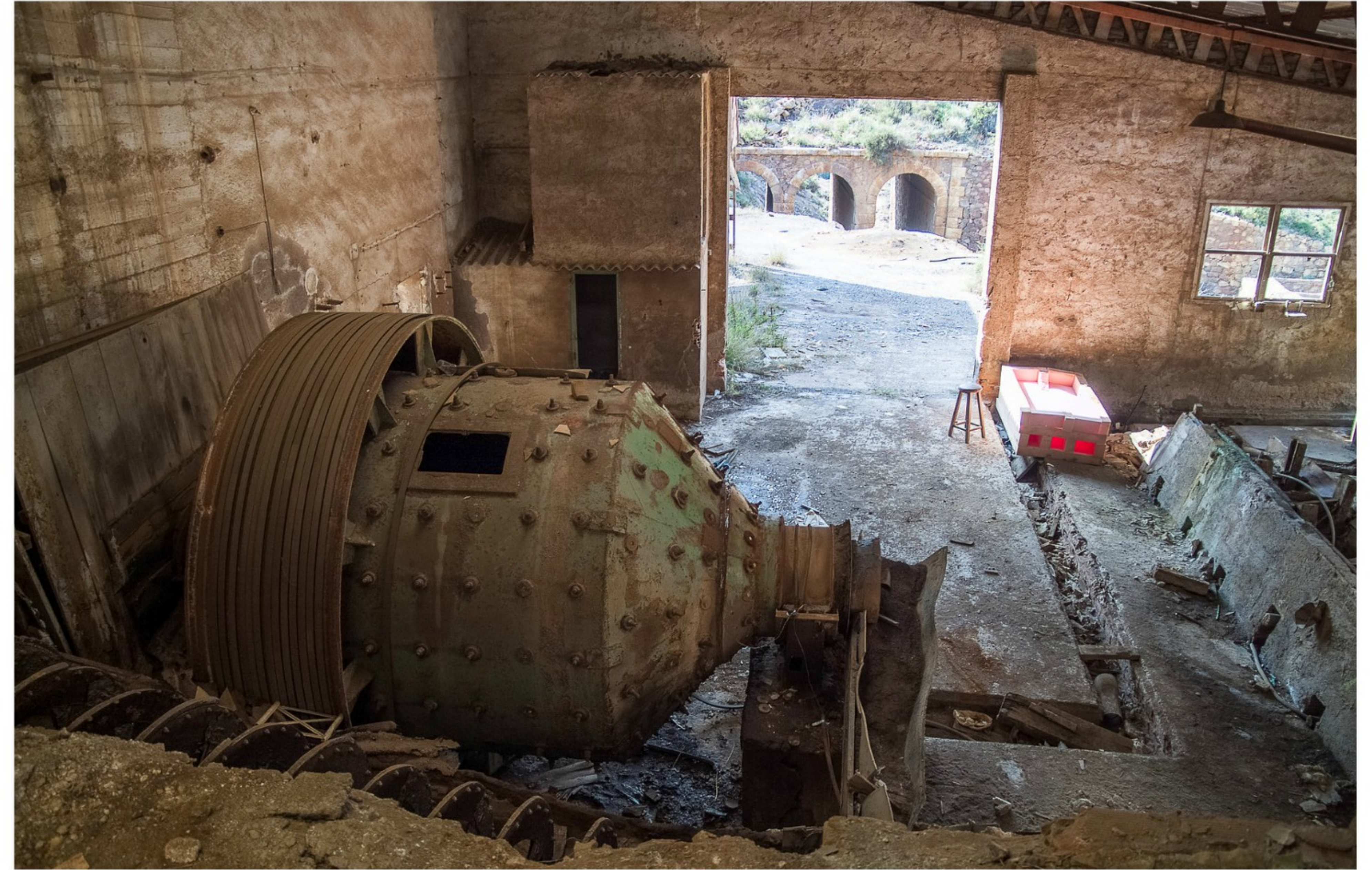
Molino de bolas y tornillo de Arquímedes del Lavadero El Galo o El Arresto. En este camino de servicio destaca junto al lavadero "El Arresto" un emblemático puente con tres grandes ojos o arcos de medio punto del siglo XIX, que conduce a la Bahía de El Gorguel.
