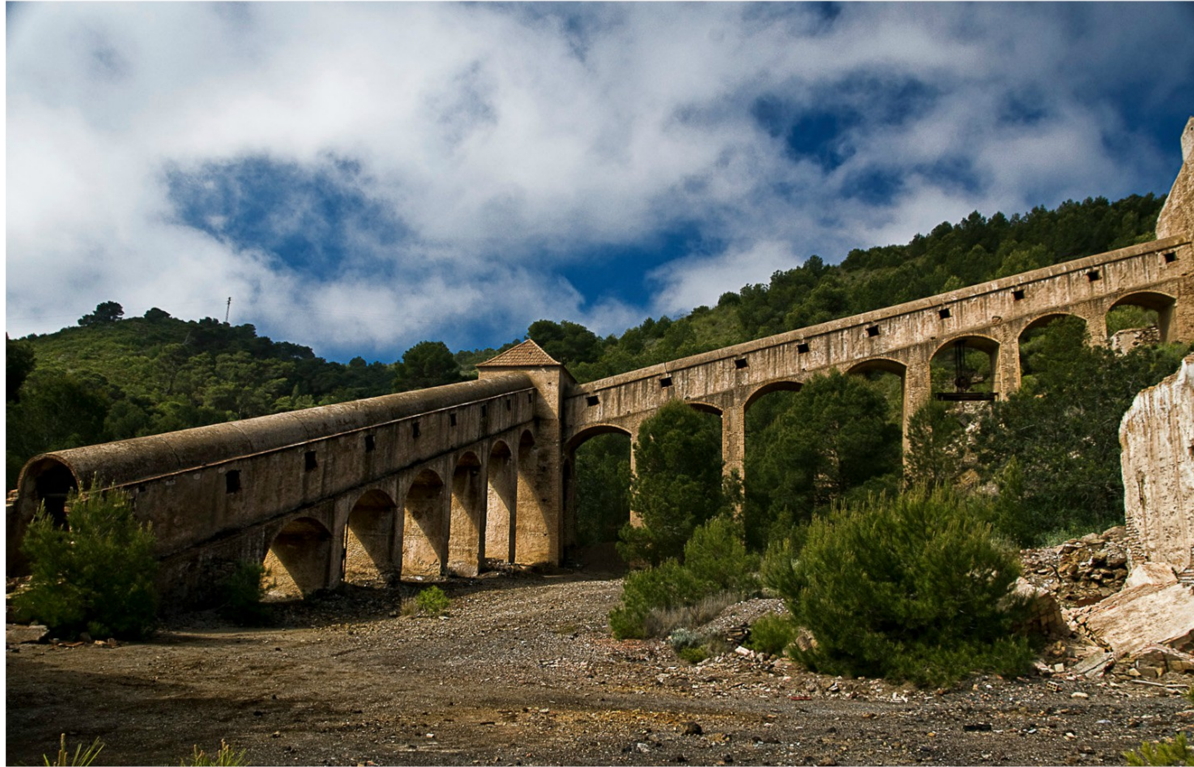
Mina El Lirio - Llano del Beal Conjunto de construcciones frente a una galería de tunel sobre arcos de mampostería, en bastante buen estado y solidez. El resto de instalaciones exteriores están en estado de ruina, restos de oficinas, archivos, máquina de extracción, lavadero y vagonetas. Esta explotación se mantuvo en funcionamiento hasta mediados de los años 70, su falta de rentabilidad obligo al cierre.
