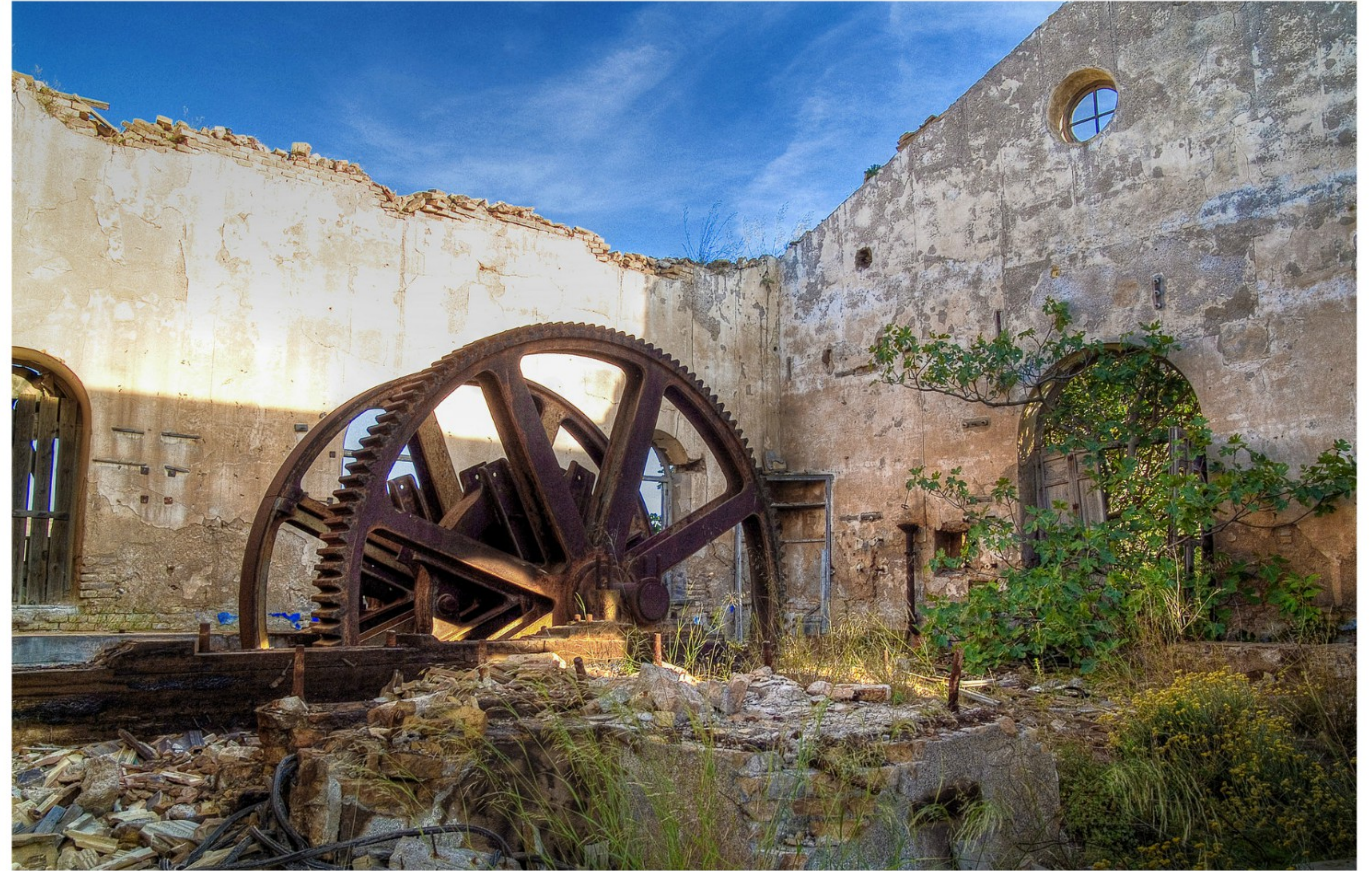
Rueda de extracción Mina Iberia Cabezo Rajao - La Unión
